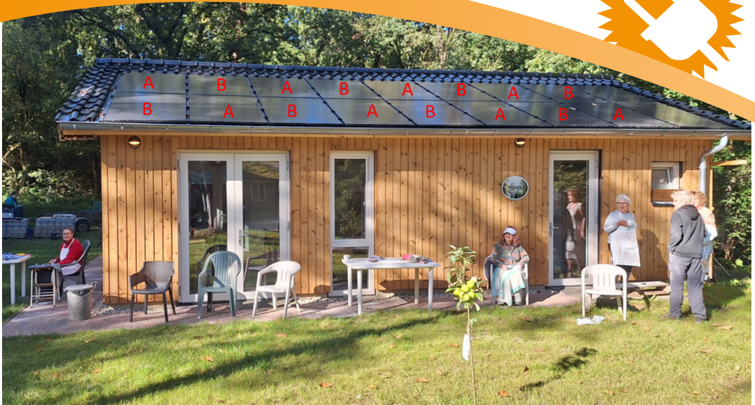
Het Boshuis, vooraanzicht, met de zonnepanelen: 'A' = Growatt string omvormer, 'B' = SolarEdge omvormer, met optimizers.
