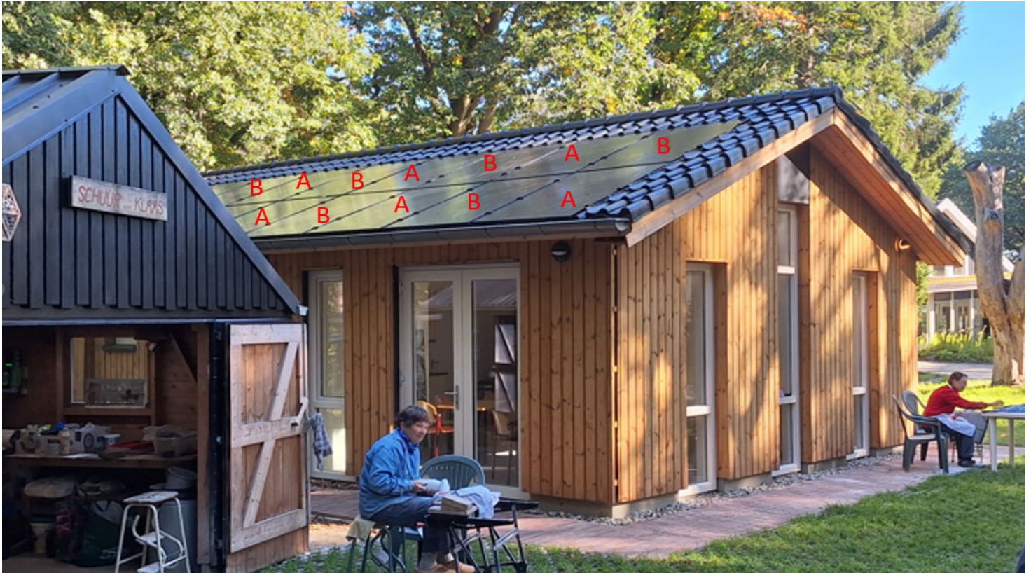
Het Boshuis, zijaanzicht. De zonnepanelen zijn om-en-om verdeeld over twee strings: 'A' = Growatt string omvormer, 'B' SolarEdge omvormer, met optimizers.
